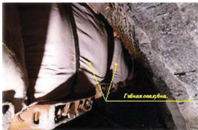
Рис. 3. Гибкий рукав с забутовочной смесью после окончания работ
