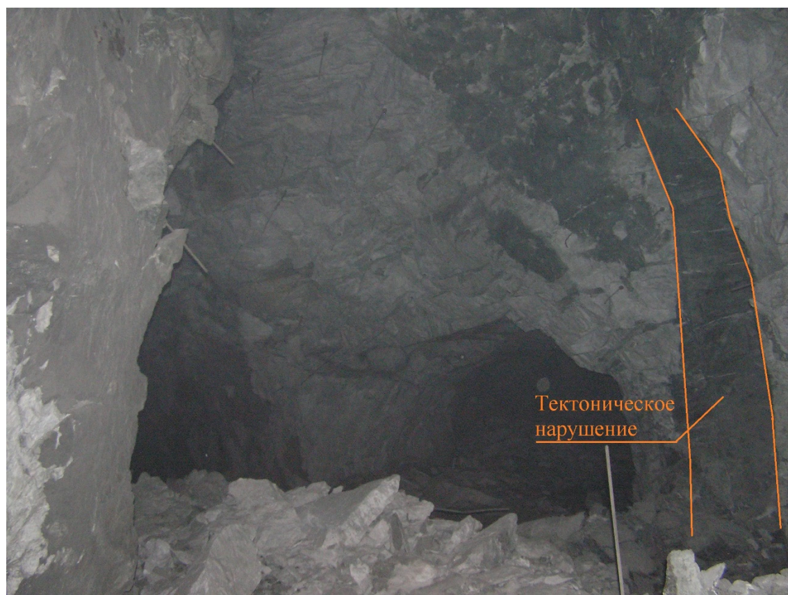
Рисунок 19 - Пример действия механизма разрушения массива вблизи тектонического нарушения
