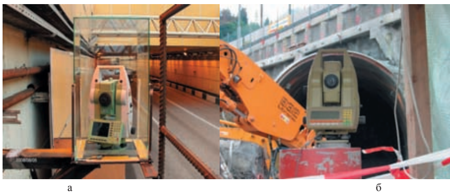
Рис. 7. Мониторинг тоннелей: а) в России, б) в Швейцарии
