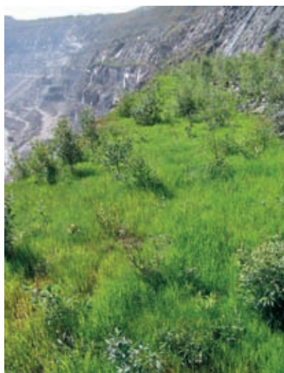
Рис. 1. Вид предохранительной бермы карьера рудника «Железный» ОАО «Ковдорский ГОК» после создания дернины
