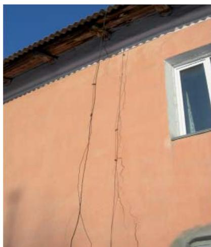
Рис. 2. Трещина в наружной торцевой стене дома
