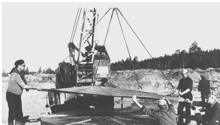
Рис. 1. Подготовка к взрыву заготовки для трубных решеток, 1971 г.
