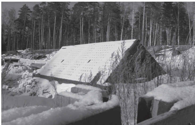
Рис. 1. Арочное укрытие места взрыва заряда
