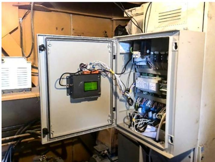
*Рисунок 5.6 – Аппаратура для регистрации и беспроводной передачи данных [21]*
