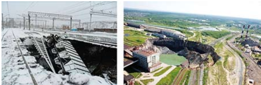
Рис. 1. Аварийные провалы в пределах подработанной территории в г. Березники Пермского края
