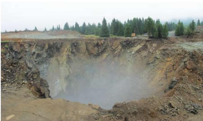
**Рисунок 4.5.** Обрушение земной поверхности на Южном фланге Сарановского месторождения
