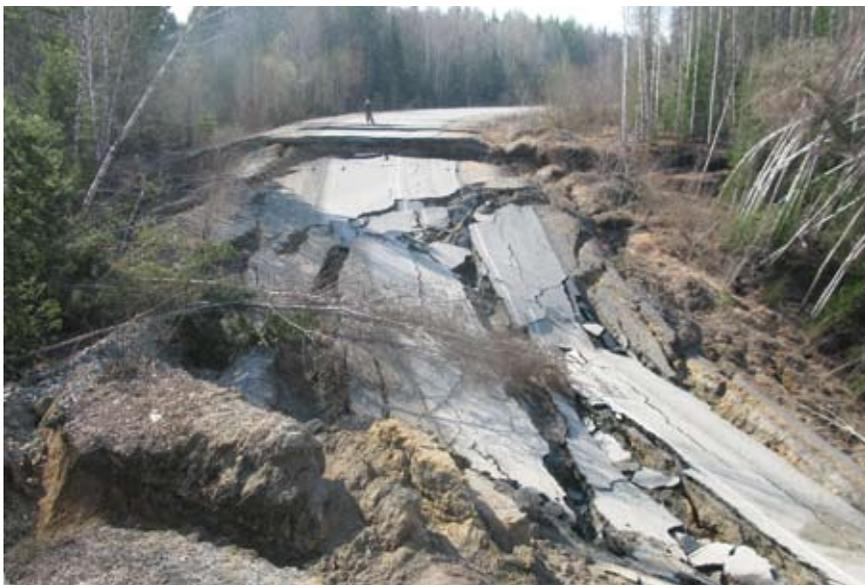
**Рисунок 4.2.** Провал земной поверхности над Южной залежью
