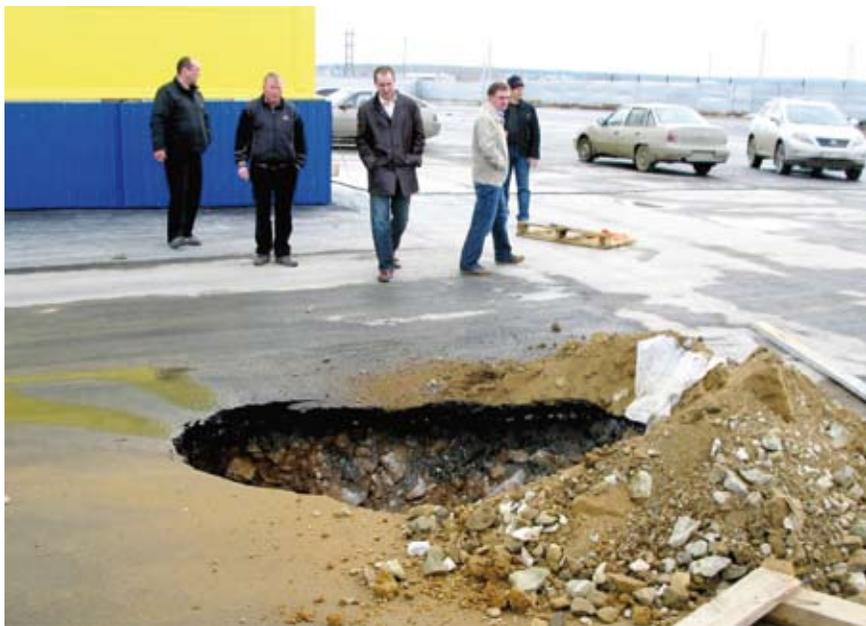
**Рисунок 3.33.** Территория г. Березовский. Образование провала над старательской горной выработкой. Горнотехническая документация по данной выработке отсутствует
