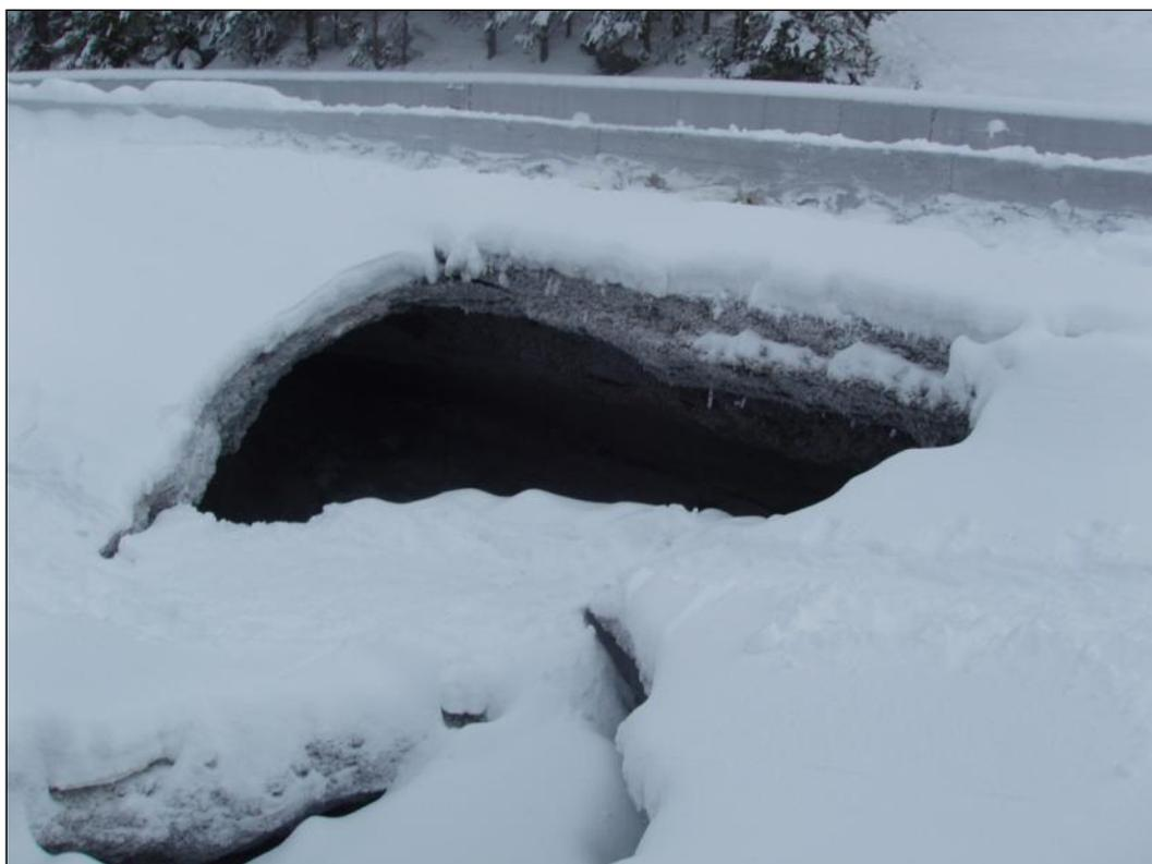
Рисунок 1.8 – Карстовый провал в основании канала р. Вагран
