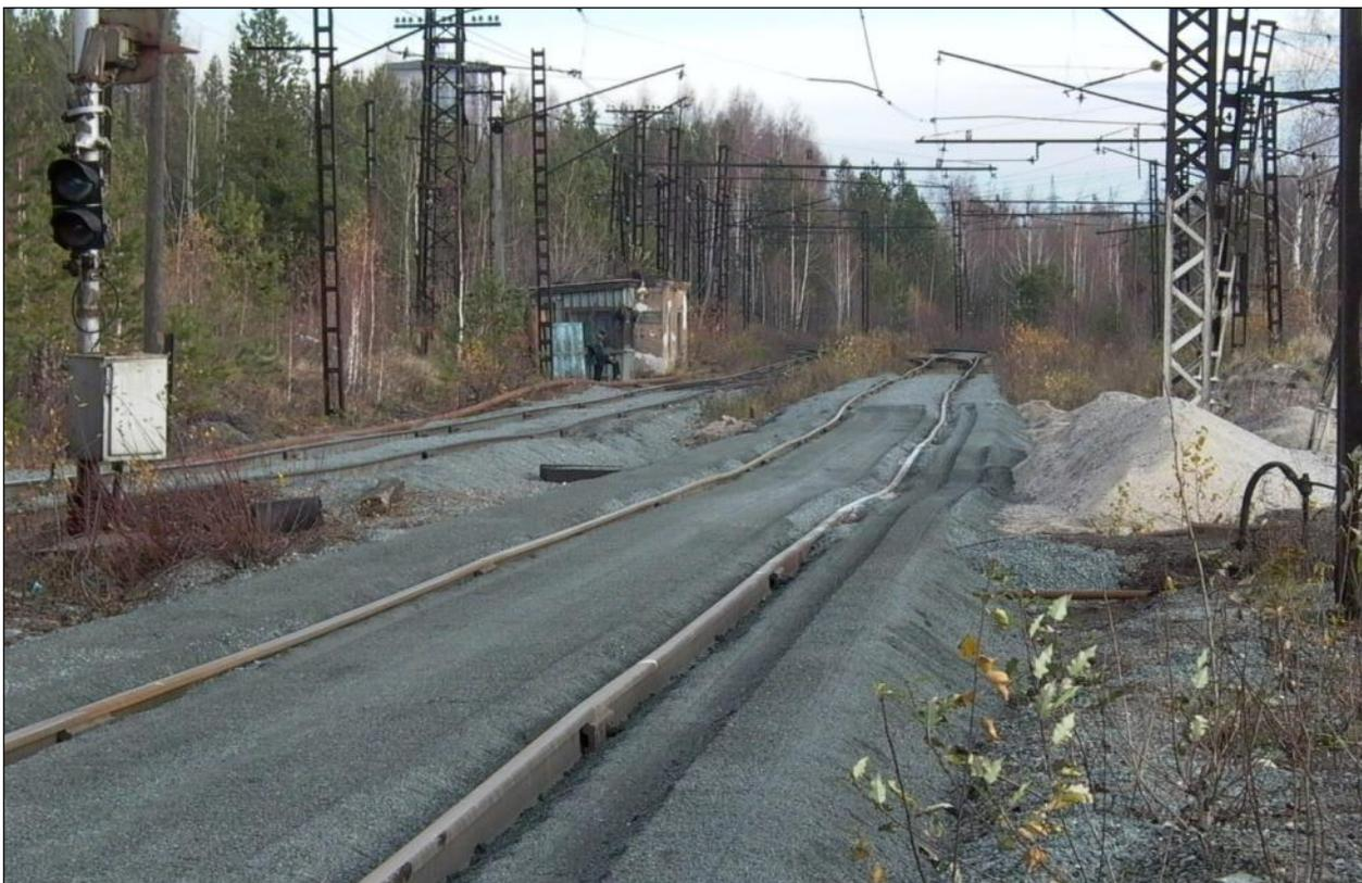
Рисунок 1.7 – Зона плавных деформаций карстопроявления на участке железнодорожного поста №12 Высокогорского ГОКа
