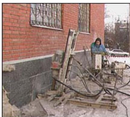
Рисунок 4.15 – Комплект специального малогабаритного оборудования для изготовления буроинъекционных свай и бурение наклонной скважины
