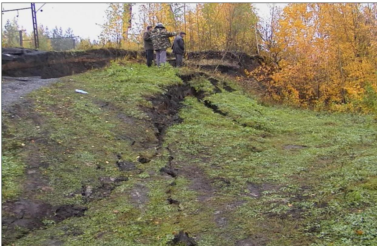
Рисунок 1.6 – Воронка обрушения на Высокогорском ГОКе
