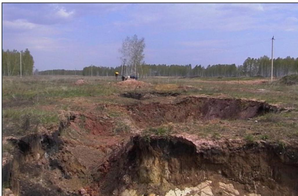
Рисунок 5.1 – Карстовые провалы на Красногорском участке газопровода
