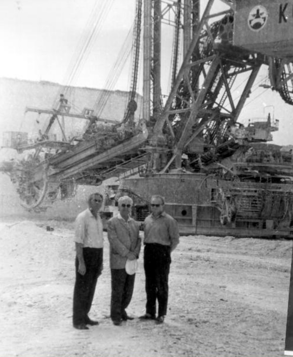
М.В.Васильев на месте строительства линии ЦПТ на Стойленском ГОКе
