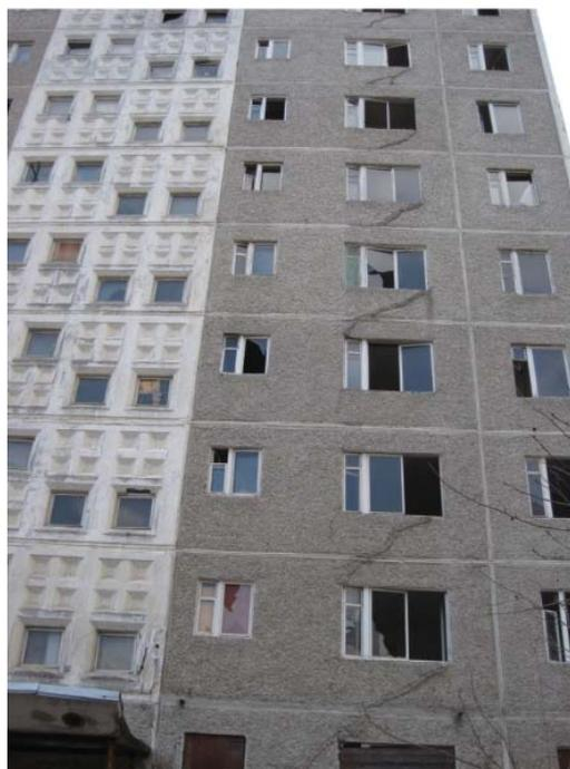
Рис. 1. Аварийный отселённый девятиэтажный дом № 6 на ул. Мусоргского в Екатеринбурге. Видны зоны деформации северной стены дома в центральной части дома между вторым и третьим подъездами.
