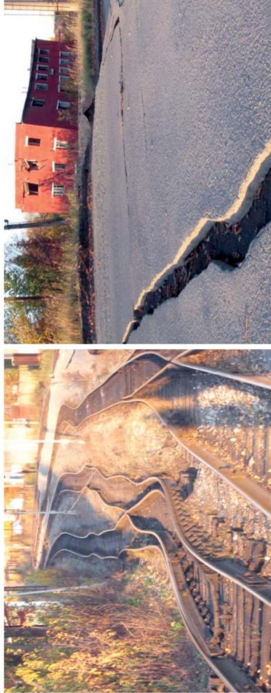
Рис. 4. Деформации железнодорожных путей и здания проходной в результате геодинамической подвижки
