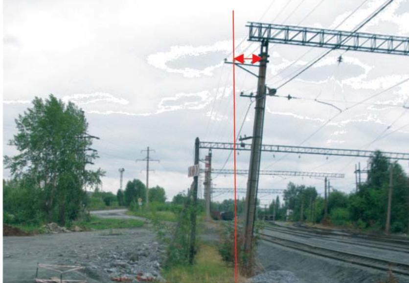
Рис. 8. Крен опор контактного провода после проведения взрыва 11.07.2010 г.
